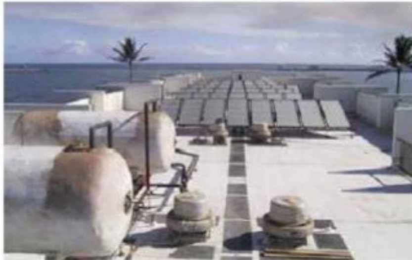
الشكل (٩-١٣) : الأجهزة التي تستقطب الطاقة الشمسية وتحولها إلى أشكال أخرى للطاقة أصبحت أكثر شيوعاً. ويحول سخان الماء الذي يعمل بالطاقة الشمسية هذه الطاقة مباشرة إلى حرارة ترفع درجة حرارة الماء. كما أن لوح الطاقة الشمسية يحول الطاقة الشمسية إلى طاقة كهربائية.
